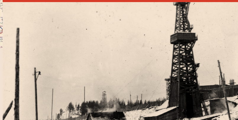
Одна из скважин Краснокамского нефтяного месторождения. 1940-е гг.
